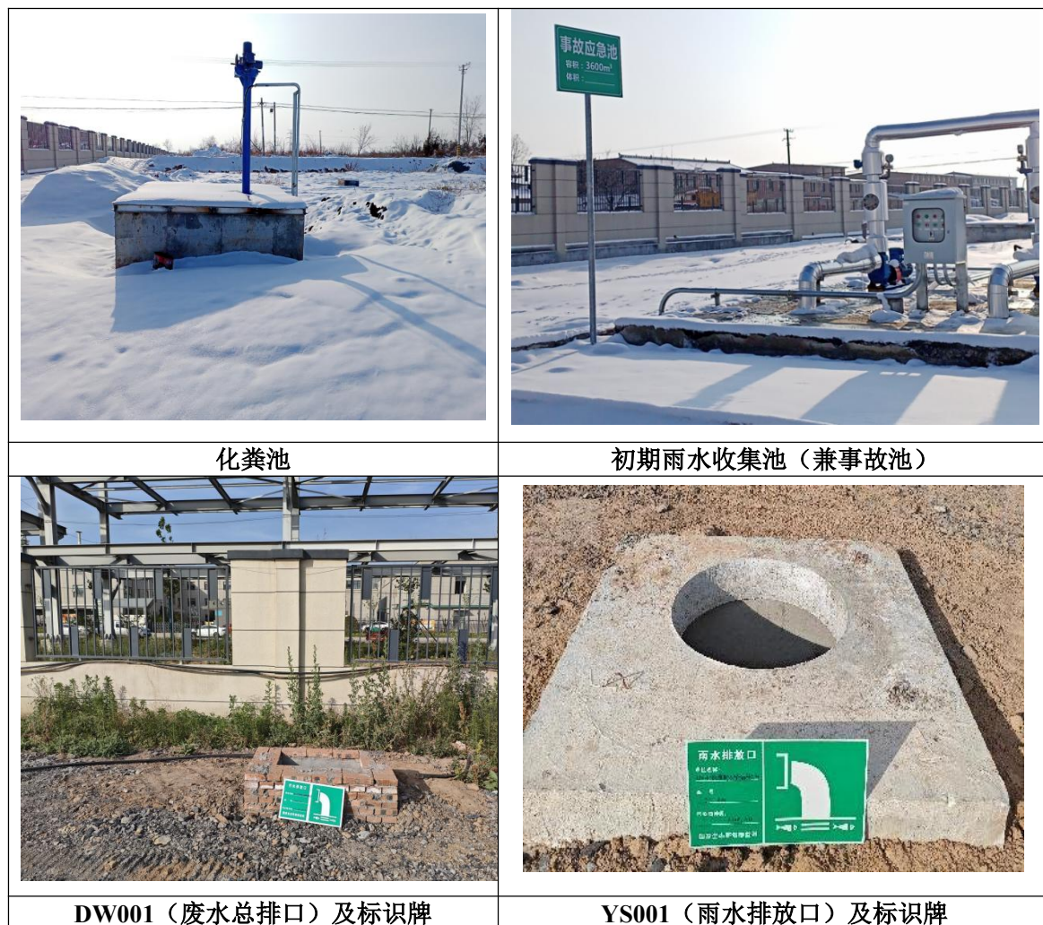
图 4.1-2 废水排放口建设情况
